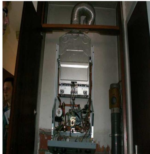
Figure 7.18: chaudière atmosphérique murale au gaz de type B<sub>11</sub>
