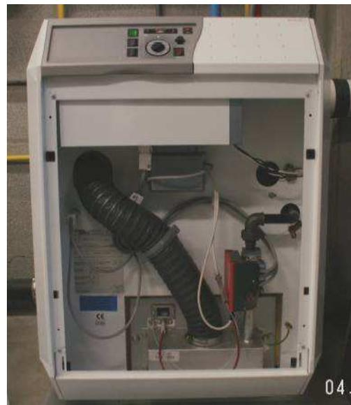
Figure 7.20: chaudière au gaz HR+ à évacuation forcée des fumées (type C)
