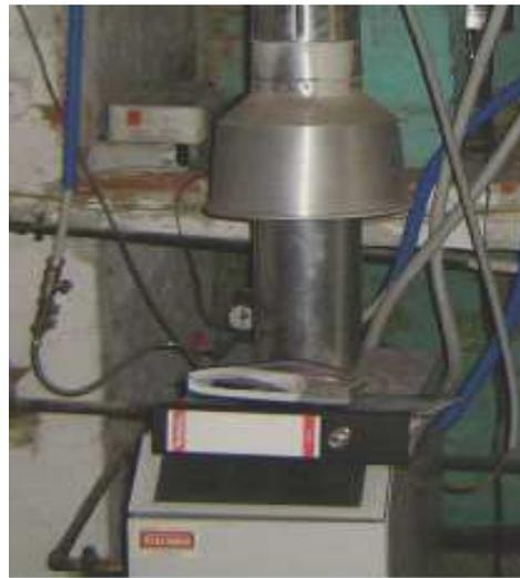
Figure 7.14: chaudière avec anti refouleur/coupe-tirage
