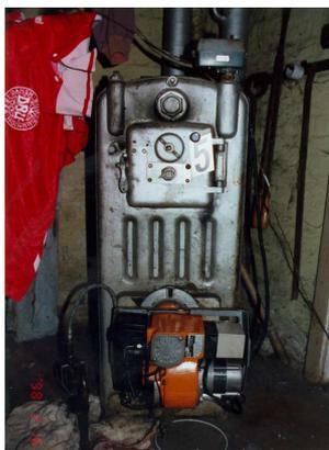
Figure 7.1: exemple extrême d'une vieille chaudière non isolée
