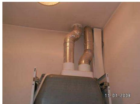
Figure 7.22: appareil fermé (type C)
