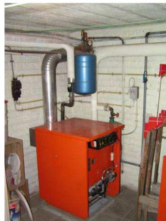
Figure 7.16: chaudière atmosphérique de type B<sub>11</sub> avec évacuation des fumées
