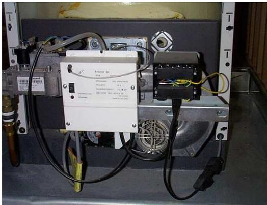
Figure 7.23: chaudière au gaz avec petit ventilateur(brûleur premix)
