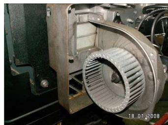
Figure 7.12: brûleur avec clapet d'économie
