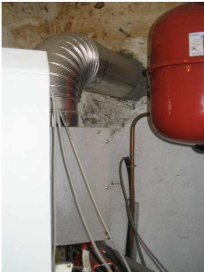
Figure 7.17: évacuation des fumées (chaudière HR+)
