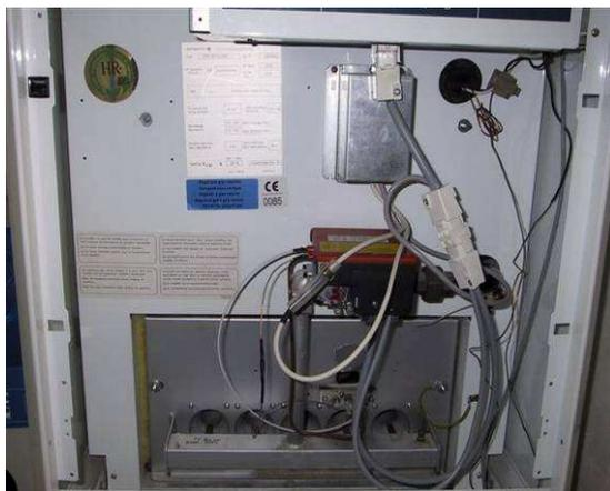
Figure 7.15: brûleur prémix d'une chaudière atmosphérique au gaz de type B<sub>11</sub>
