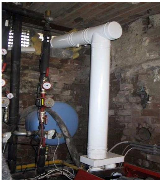
Figure 7.19: chaudière à condensation au gaz naturel avec arrivée d'air fermée
