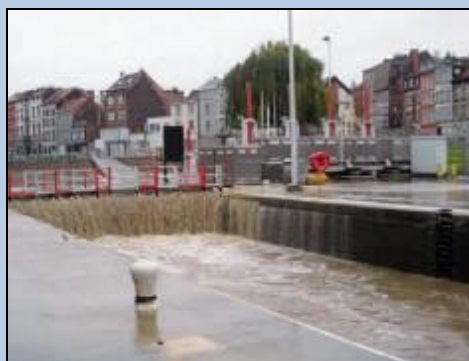
Photo 5-1 : Débordement d'une écluse du port de Bruxelles
