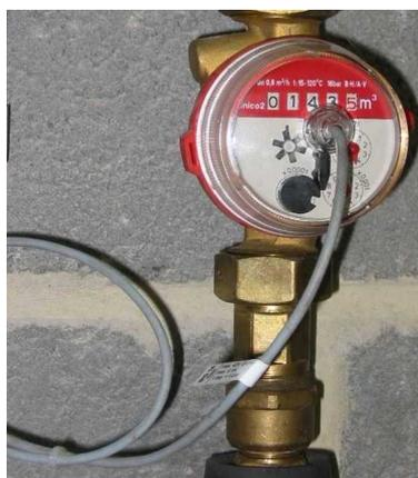
Par ailleurs le compteur de passage, placé sur l'eau froide alimentant exclusivement le ballon de stockage, comptabilise le nombre de litres (m<sup>3</sup>) d'eau chaude utilisée.
