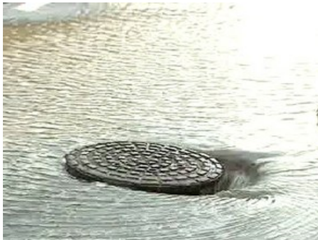
L'eau de pluie ruisselle du toit dans les égouts et se mélange aux eaux usées. En cas de fortes pluies, les égouts ne peuvent pas les absorber et débordent, créant ainsi d'importantes inondations, laissant les eaux usées affluer dans la rue. (Photo: Brusselnieuws.be)
