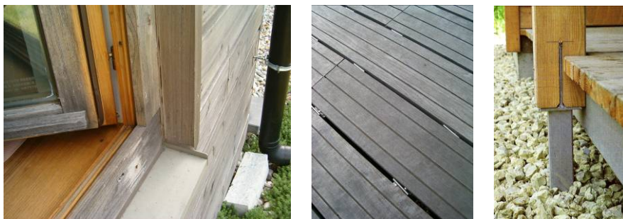
A gauche: pour des raisons techniques, les menuiseries extérieures peuvent être peintes ou lasurées, du bois de classe de durabilité I, II ou III peut également être utilisé non-traité. Milieu : le bois clipsé peut sécher de tous les côtés. A droite : le contact direct avec le sol sera évité pour les jeux ou les terrasses en bois.
