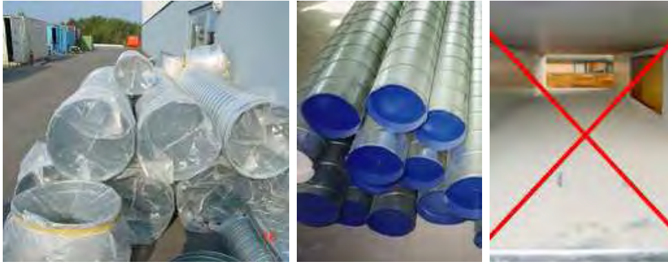
Mise en œuvre sur chantier (Source : CSTC)
