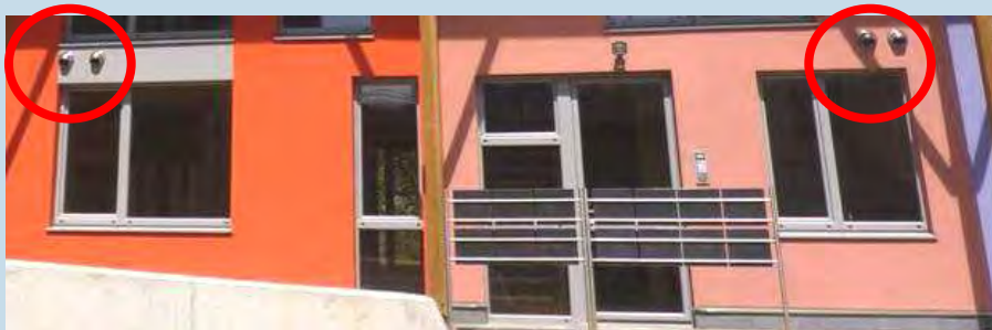
Façade avant du bâtiment ESPOIR, (Source : Architecte D. Carnoy):
