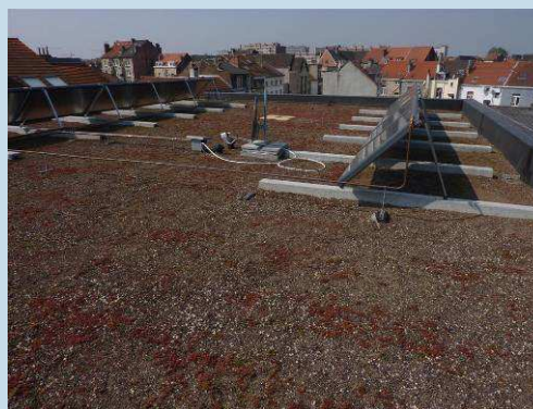
Figure 1: toiture verte + chauffe eau solaire (Source : Architecte D. Carnoy)
