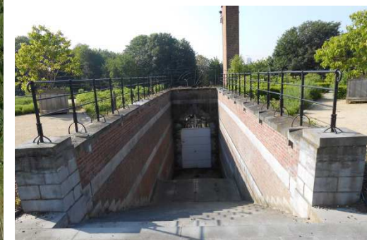
Par l'escalier central
