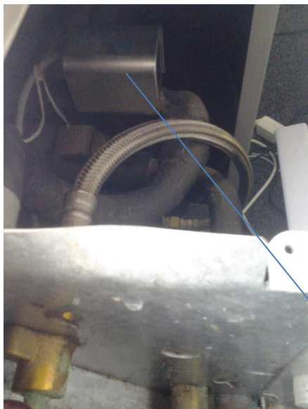
Figures 2.20 vanne 2 voies en amont de la batterie d'eau glacée d'un ventilateur-convecteur et son élément de commande : le thermostat
