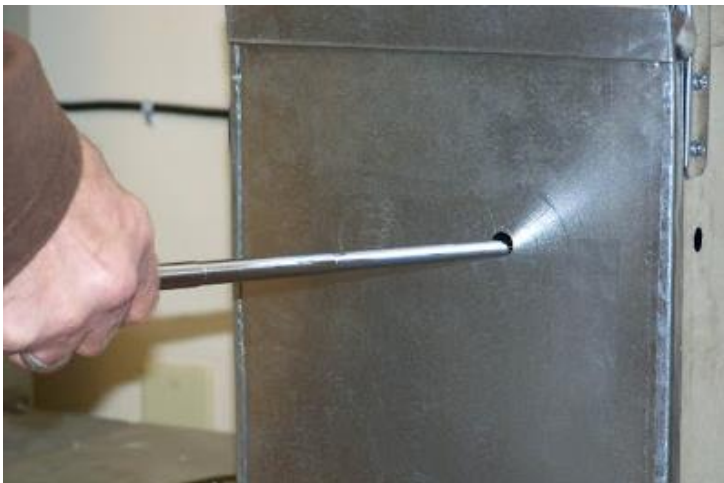
Figure 2.2 exemple de mesure de vitesse d'air dans un conduit de ventilation
