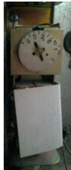
Figures 2.20 vanne 2 voies en amont de la batterie d'eau glacée d'un ventilateur-convecteur et son élément de commande : le thermostat
