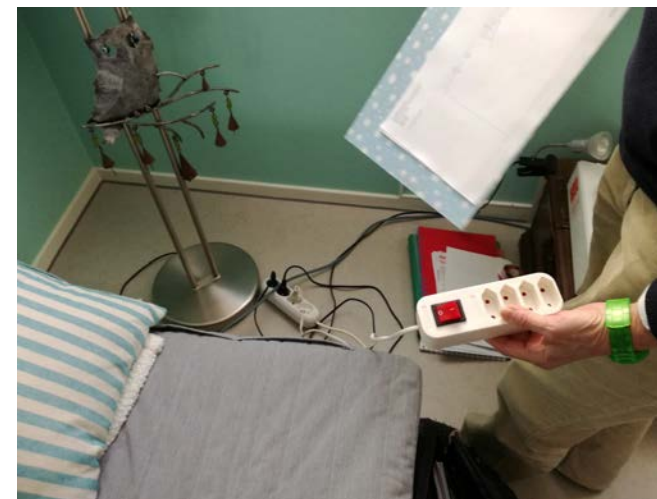
Placement de multiprises équipées d'un interrupteur
