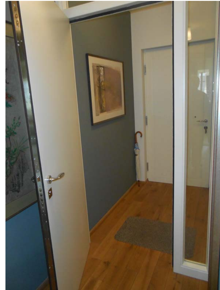
Construction d'un sas d'entrée
