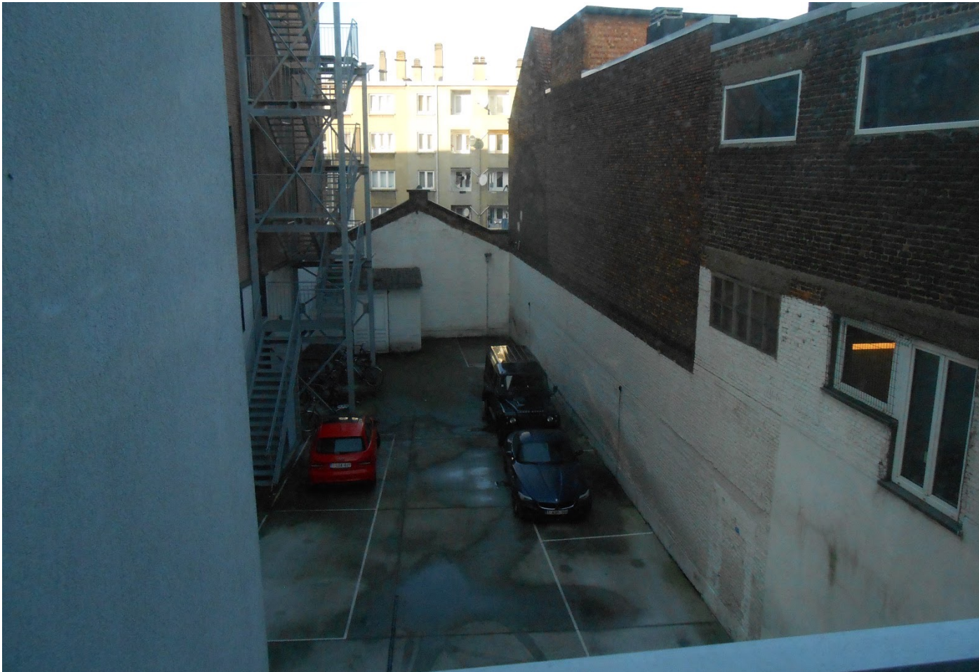
Cas Bellevue: Problème d'humidité sur la dalle du parking intérieur, à qui la responsabilité aujourd'hui ?
