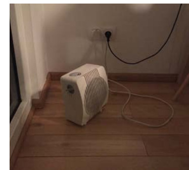
Ajout de radiateurs électriques
