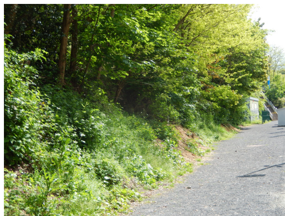
Talus bordant le quai (photo A.-M. Paelinck)
