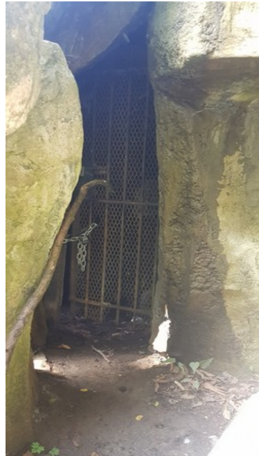
Figure 37: Photographie de l'actuel local technique dans la rocaille - Photographie Noémie Pons-Rotbardt, juillet 2021
