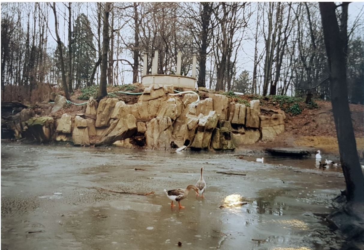
Figure 35: Photographie de chantier de la réparation des rocailles du ruisseau, sans date - Archives du service Vert, Commune d'Uccle
