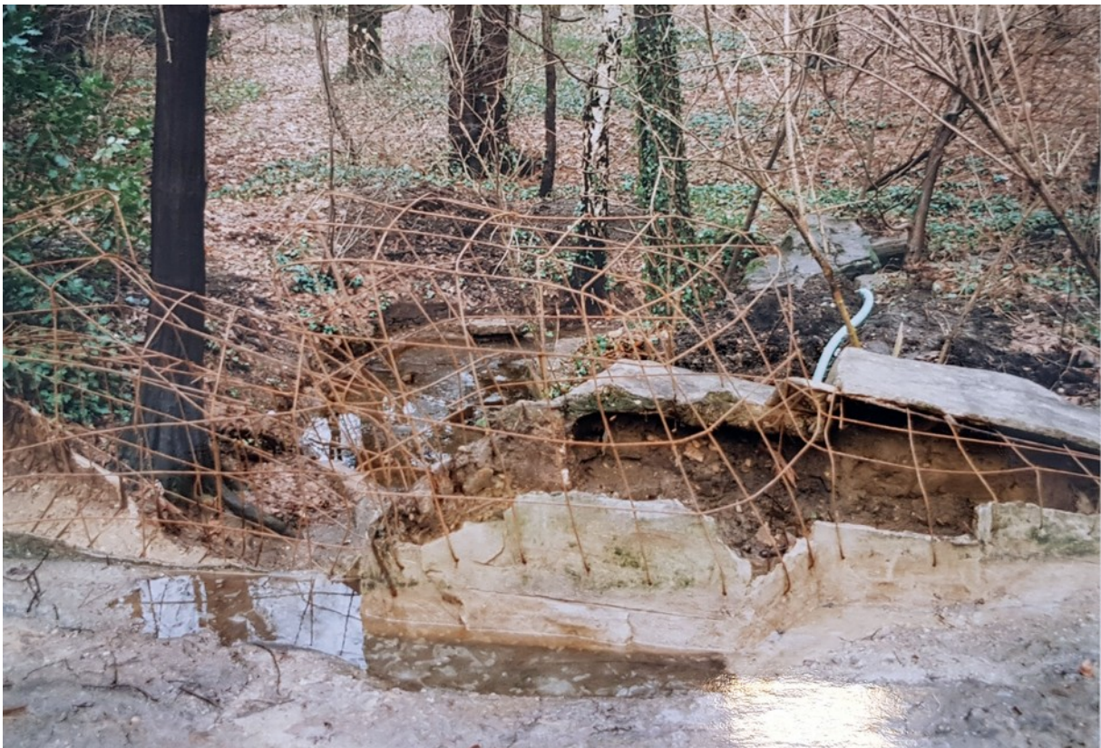
Figure 33: Photographie de chantier de la réparation des rocailles du ruisseau, sans date - Archives du service Vert, Commune d'Uccle
