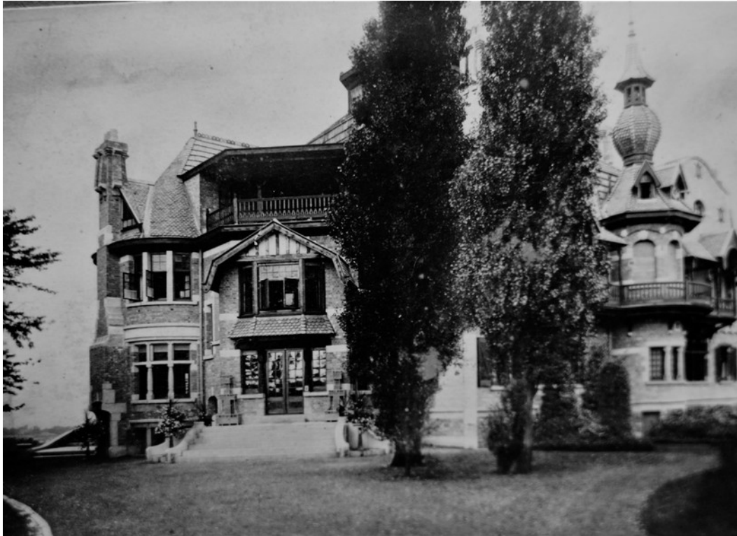
Figure 11: Photographie de la façade sud-ouest du château de La Sauvagère. Archives personnelles des héritiers d'Albert Blicck
