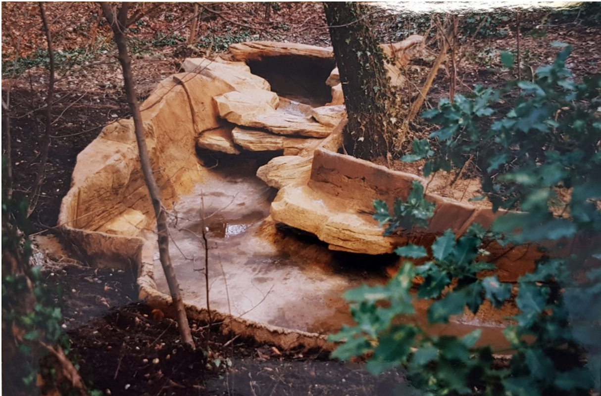
Figure 34: Photographie de chantier de la réparation des rocailles du ruisseau, sans date - Archives du service Vert, Commune d'Uccle
