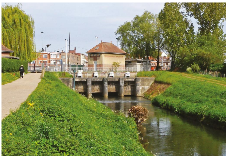
Photo 4.14. Déversoir de Aa, site de nidification de l'Hirondelle rustique sur la Senne (2021) (© Escaut sans frontière / Coordination Senne)
