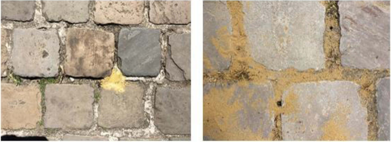
Figure 5 - illustration des modalités de la variable qualitative « type de joint ». Joint rigide dégradé (à gauche) et joint non lié (à droite). Crédit photo : V. Van Keymeulen
