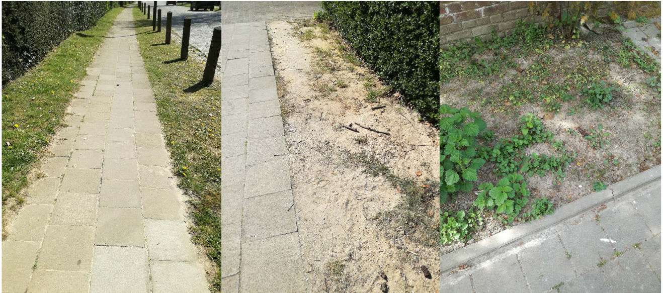
Figure 25 – Trottoirs présents dans la commune d'Uccle qui disposent de parterres enherbés ou sans végétation permettant l'accueil des espèces d'Hyménoptères terricoles.
