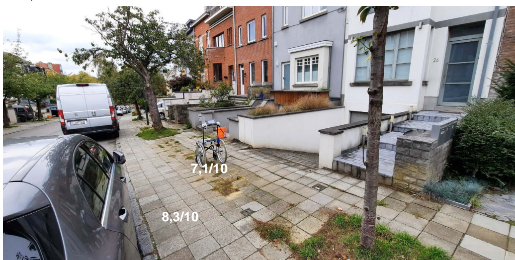
Figure 22 – Résultat du niveau confort de l'Avenue Coloniale 24 à Watermael-Boitsfort sur la partie centrale contenant les sites de nidification, et sur une partie de revêtement située à côté des nids.
