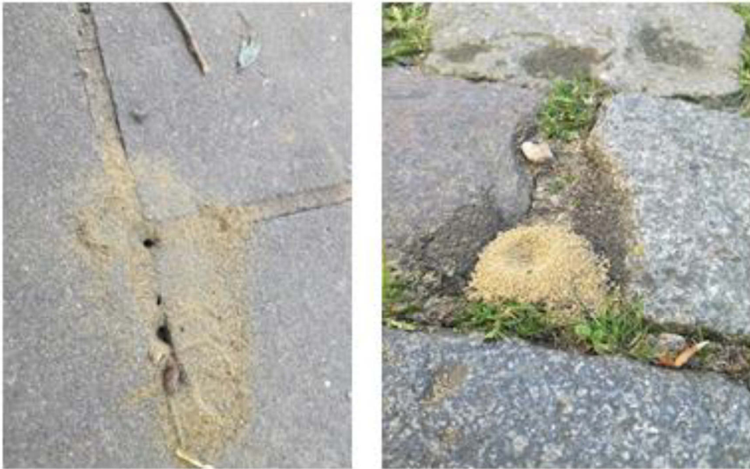
Figure 3 - Illustration de nids de fourmis (à gauche) et d'abeilles (à droite) nichant dans les trottoirs. Crédit photo : V. Van Keymeulen
