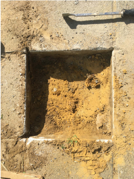
Figure 19 – Fouille du CRR sur l'Avenue Coloniale 24, Watermael-Boitsfort. À gauche : Enlèvement de la dalle en béton. À droite : Dalle de béton et épaisseur du mortier de profil. Photo : Sylvie Smets.
