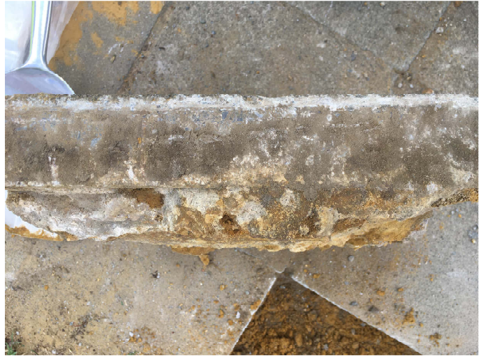
Figure 19 – Fouille du CRR sur l'Avenue Coloniale 24, Watermael-Boitsfort. À gauche : Enlèvement de la dalle en béton. À droite : Dalle de béton et épaisseur du mortier de profil. Photo : Sylvie Smets.
