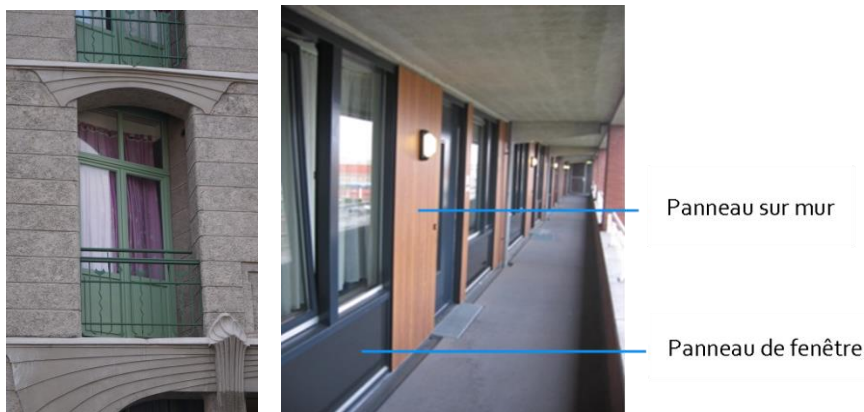
Figure 29 – Exemples de panneau de remplissage
