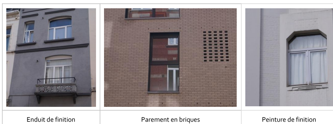
Figure 4 – Mur protégé des intempéries (Type n°2)
