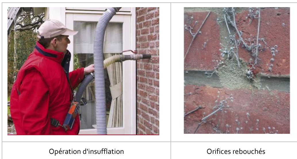
Figure 18 – Constat sur site d'une post-isolation
