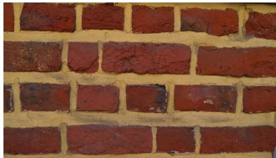
Figure 14 – Appareillage des briques: panneresse et boutisse
