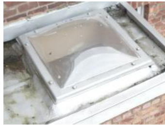
Figure 25 – Coupole à simple paroi- vitrage de type 1
