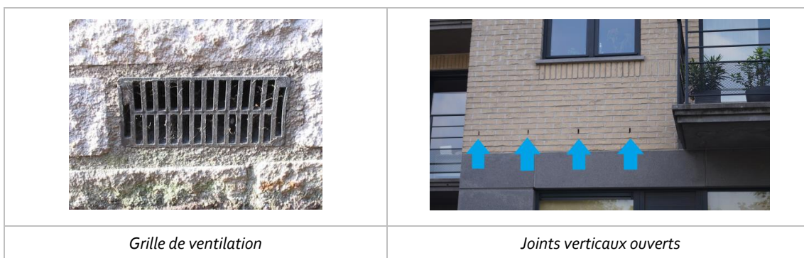
Figure 12 – Dispositifs de ventilation d'une coulisse
