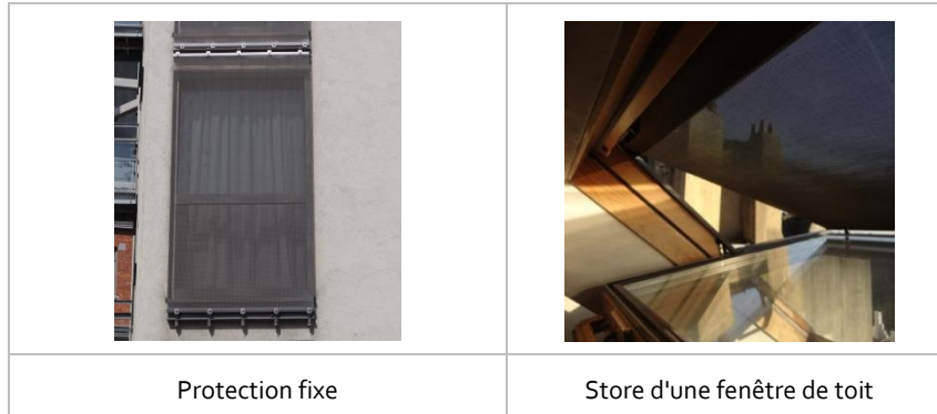
Figure 35 – Protection solaire extérieure fixe
