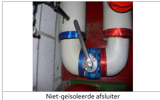
Afbeelding 44 – Gedeeltelijke isolatie van verwarmingsleiding
