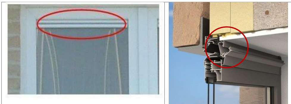
Afbeelding 68 – Toevoeropening geïntegreerd in het profiel van een venster
