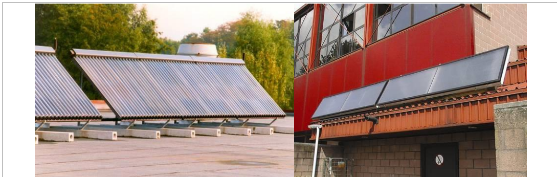
Afbeelding 67 – Zonnecollectoren
