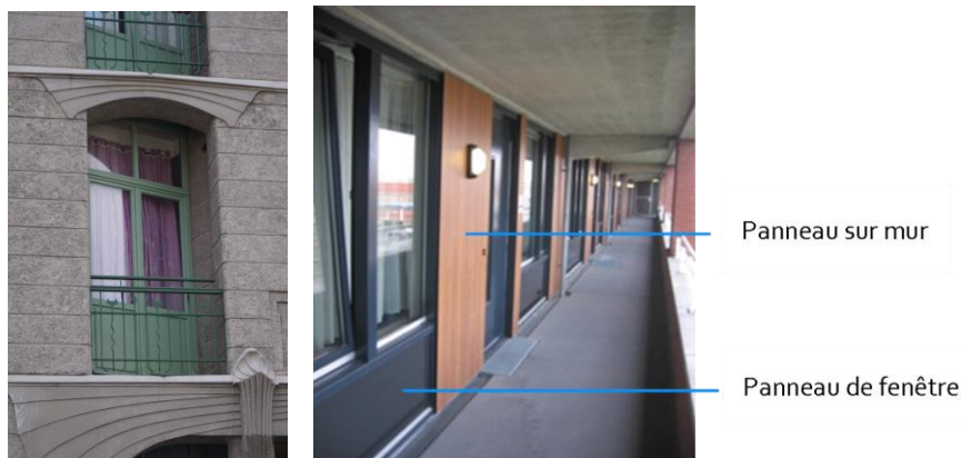
Figure 29 – Exemples de panneau de remplissage
