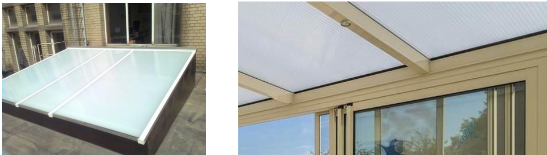
Figure 26 – Lanterneau en polycarbonate
