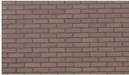
Figure 13 – Appareillage des briques: toute panneresse
