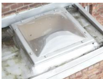
Figure 25 – Coupole à simple paroi- vitrage de type 1
