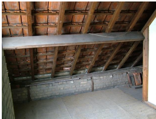
Figure 17 – Mur de pied de combles
