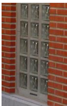
Figure 24 – Obturation de baie par des blocs de verre
