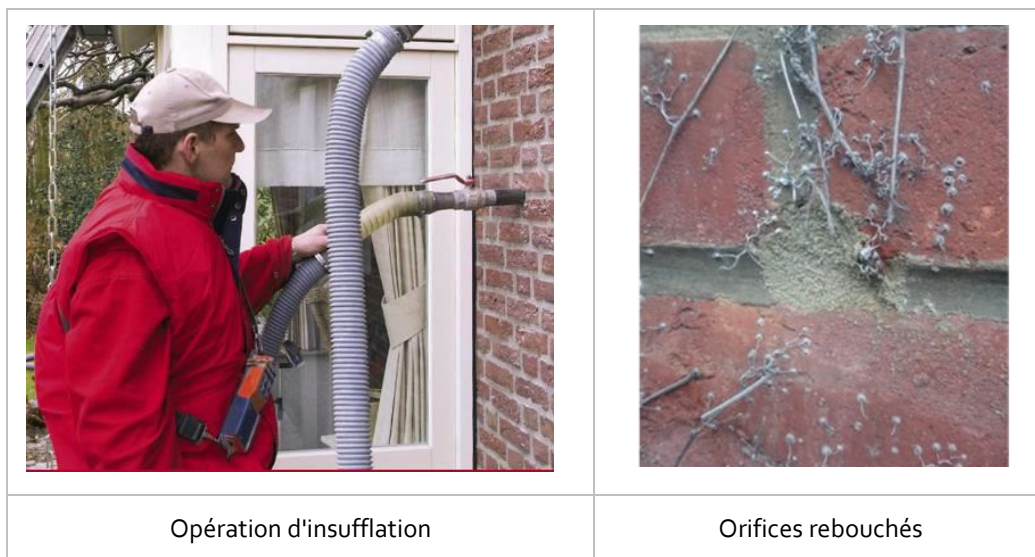
Figure 18 – Constat sur site d'une post-isolation
