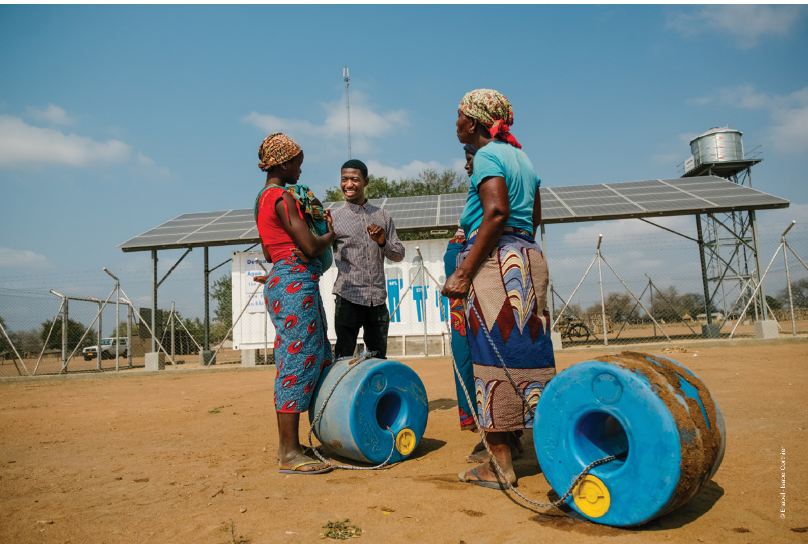
Photo: Système de dessalement utilisant l'énergie solaire pour l'alimentation de réseau d'adduction d'eau dans la province de Gaza au Mozambique. Ce projet implémenté par Enabel a été financé par la Région de Bruxelles-Capitale dans le cadre de son financement climatique international.
