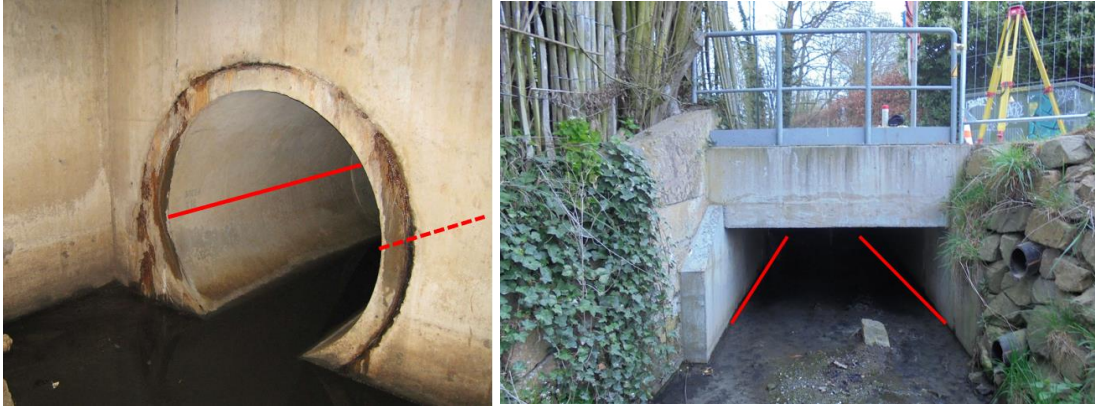
Figure 2 : Exemples du paroi du puits
