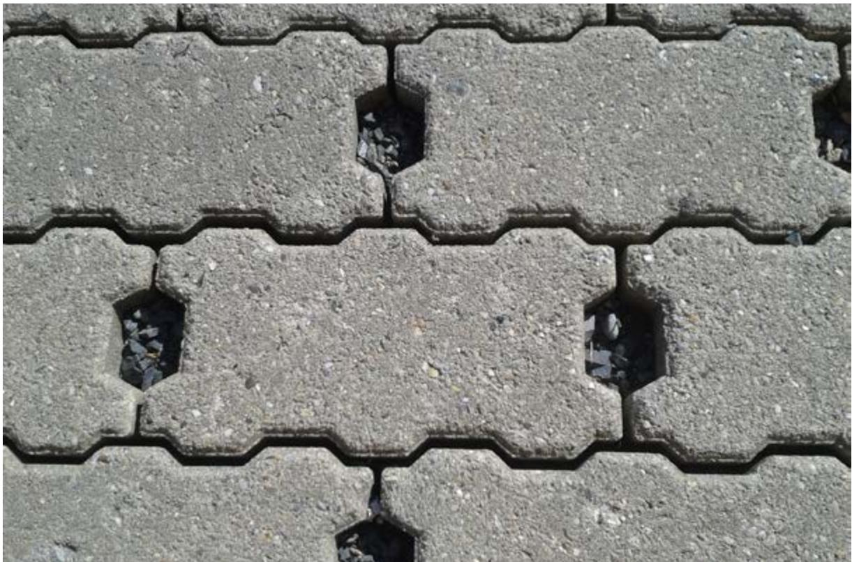
Exemple de de mise en place d'un revêtement drainant en pavé béton avec ouverture de drainage © Ecorce.
