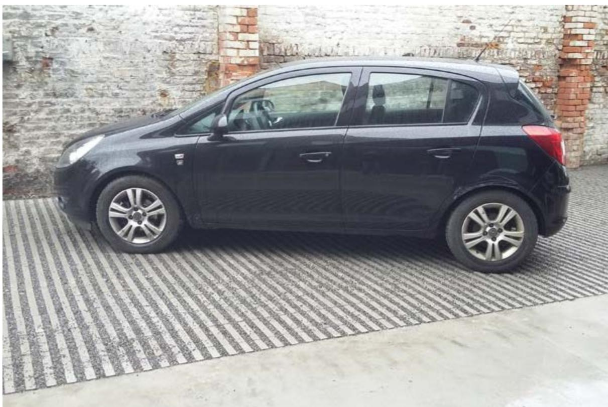
Exemple de mise en place d'un revêtement drainant en pavés béton à joints élargis, remplis gravier (Liège) © Ecorce.
