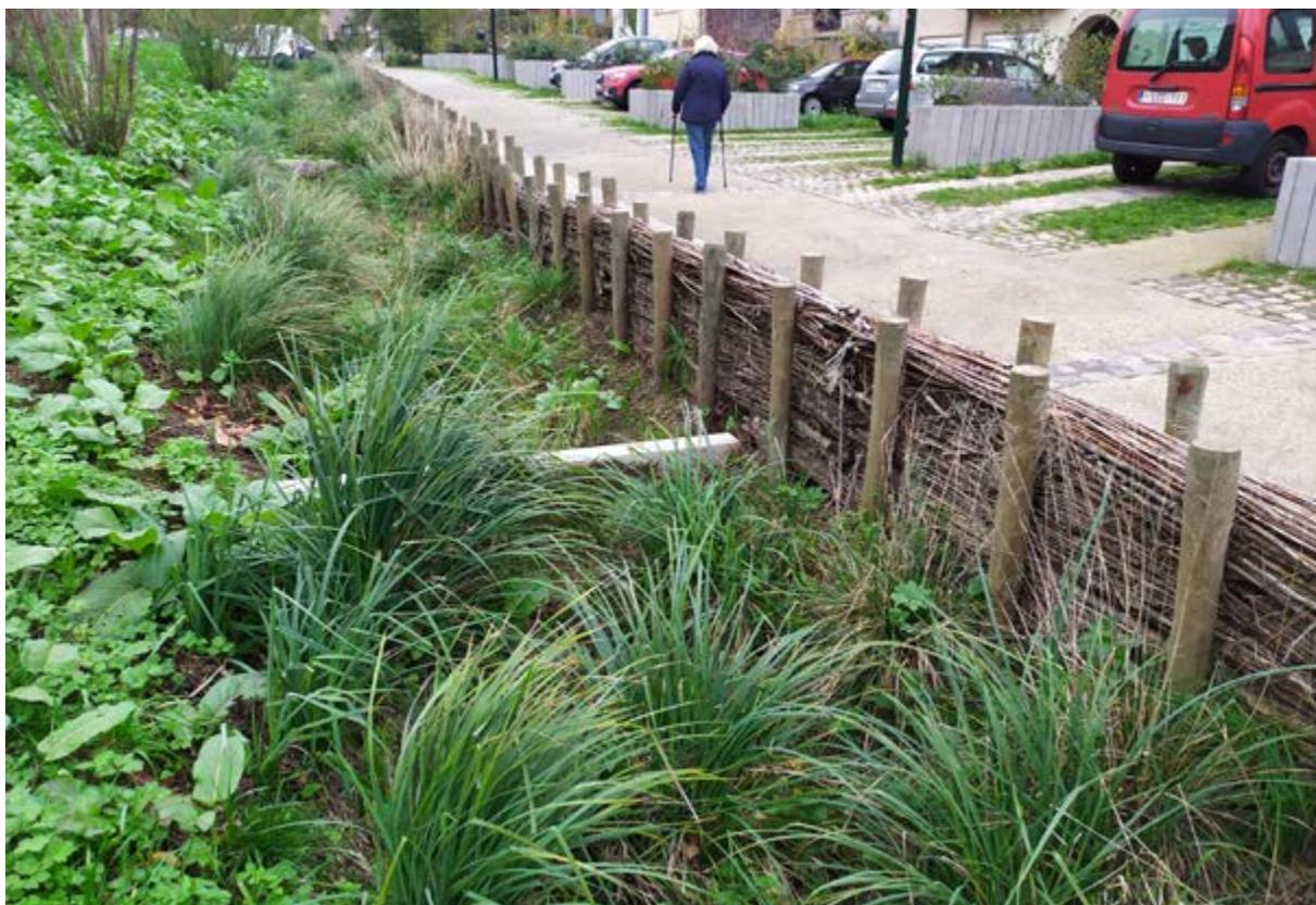
Figure 1. Fascine délimitant l'espace entre voirie et dispositif de gestion des eaux pluviales afin de protéger celui-ci des manœuvres de véhicules. (Source: Bruxelles Environnement).
