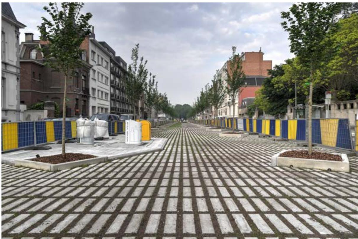
Exemple de mise en place d'un revêtement drainant en pavés béton à joints élargis (Avenue de la Liberté) © Bruxelles Mobilité.
