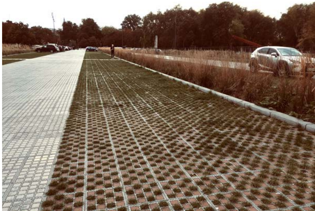
Voorbeeld van een drainerende verharding in grasklinkers © Ibram Nobels.
