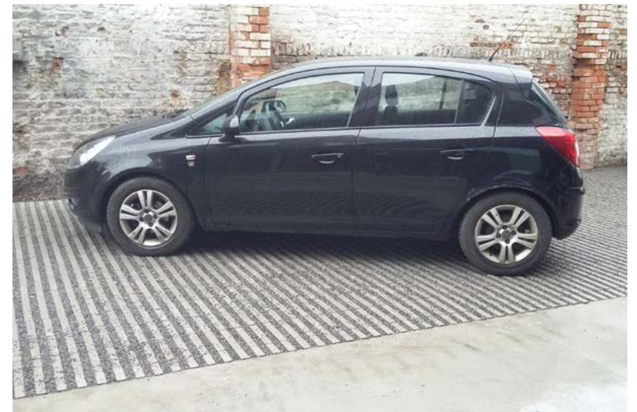
Voorbeeld van een drainerende verharding in betonklinkers met verbrede voegen, opgevuld met grind (Luik) © Ecorce.
