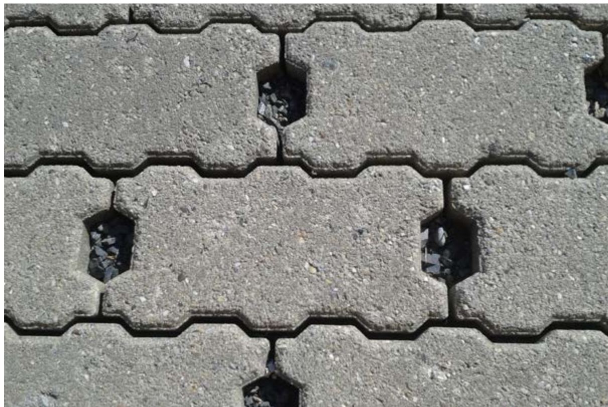
Voorbeeld van een drainerende bestrating in betonklinkers met een drainageopening © Ecorce.
