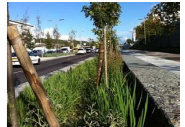
Voorbeelden van wegaanleg met aangrenzende beplante wadi's. Bron: fotobank INFRA Services.
