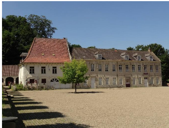
Figure 8: Revêtement en gravier meuble, Rouge Cloître, Auderghem
