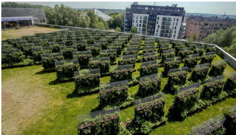
Figure 12: La toiture verte «Peas and Love » à Woluwe Saint-Lambert (Source : sillonbelge.be)
