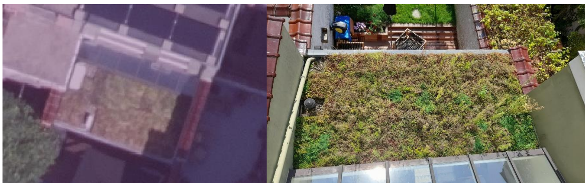
Figure 11: Toiture verte résidentielle extensive à Bruxelles – classifiée imperméable
