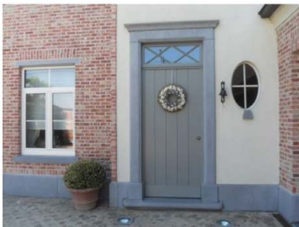
Afbeelding 36 : perimeterisolatie kan geïntegreerd worden in een gevel via een plint (voorbeeld van een plint in blauwsteen in traditionele woningbouw (foto: Nijst-natuursteen.be))
