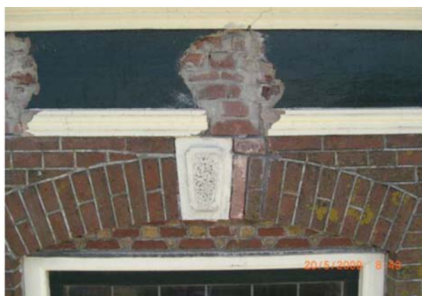
Afbeelding 106 : voorbeeld van een gevel met sierlijst en (blind)ankers, in herstelling tijdens restauratiewerken [ref. http://www.meerbouw.com/ren_min_ovz.php?pj_ID=27 ]
