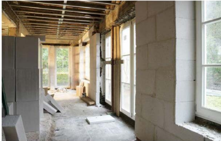
Afbeelding 183 : praktijkvoorbeeld van een raamaansluiting met binnenisolatie op basis van lichte cellenbeton [ref. Xella]
