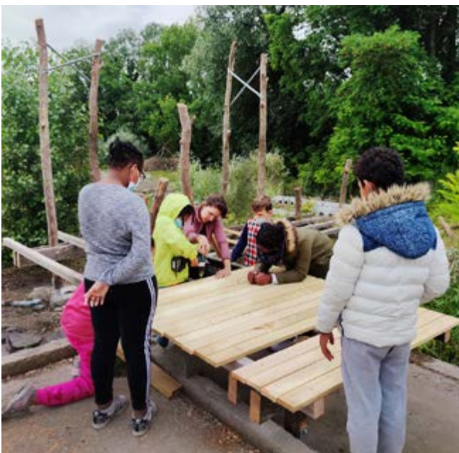
Co-construction avec des enfants, Guinguette de L'Îlo Co-constructie met kinderen, Guinguette de L'Îlo
