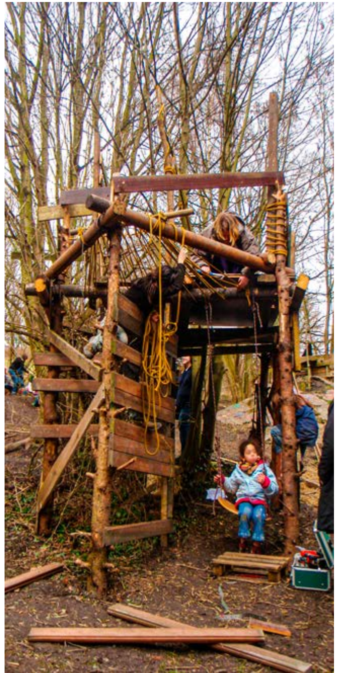
Cabane en construction, Terrain d'Aventure du Péri Hut in aanbouw, Avontureterrein Péri
