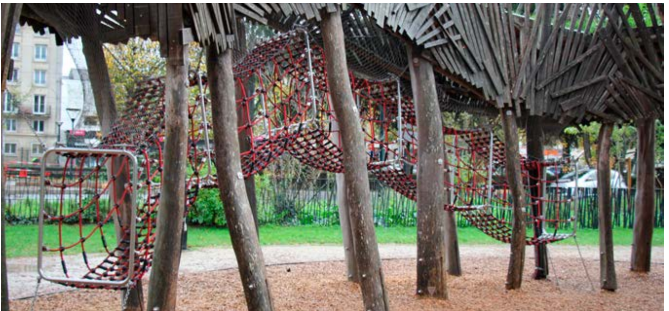
Lames de robinier en parement de la structure Latten van robiniahout voor de bekleding van de structuur
