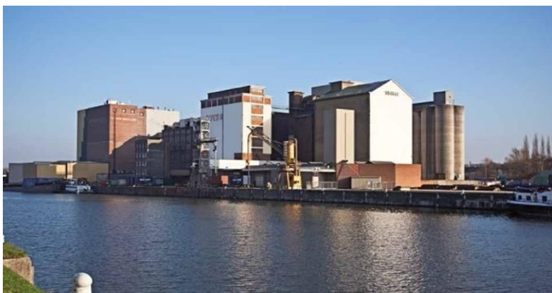
Figure 27 Meurerie Ceres - Le long de la rive est du canal, Port de Bruxelles.
