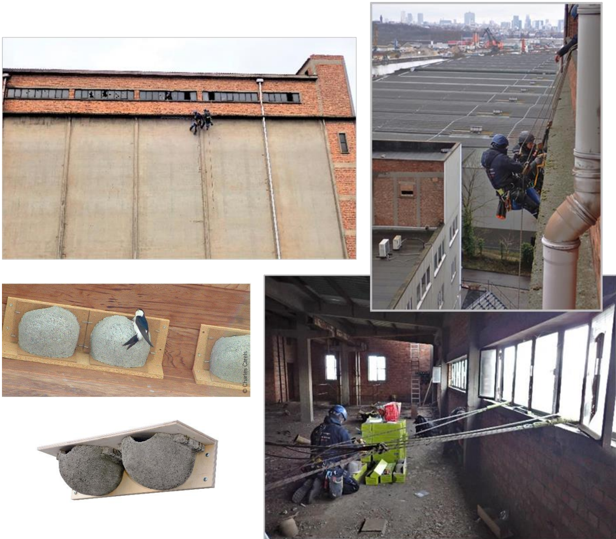
Figure 29 Installation de nichoirs doubles artificiels type Schwegler 9B (en bas à gauche) pour Hirondelle de fenêtre sur le bâtiment SILO Brussels (ancienne brasserie Meudon) en mars 2021.
