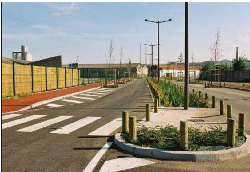
Afbeelding 38: Foto van een beplante centrale wadi (IS)
