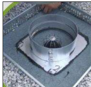
Afbeelding 47: Voorbeeld van de samenstelling van een retentiedak (SPW) Afbeelding 48: Debietbeperker op dak (Débit-co)
