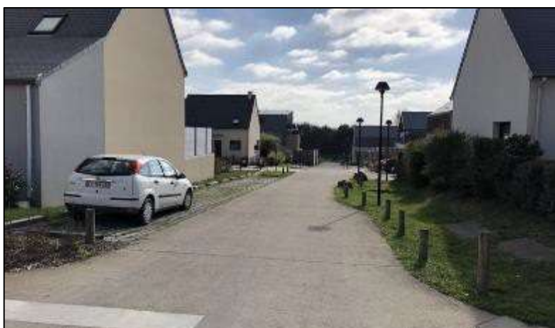
Afbeelding 40: Foto van een verkavelingsweg met een afwateringsstructuur (IS)
