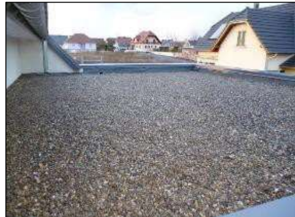
Afbeelding 44: Grinddak (Soprema)
