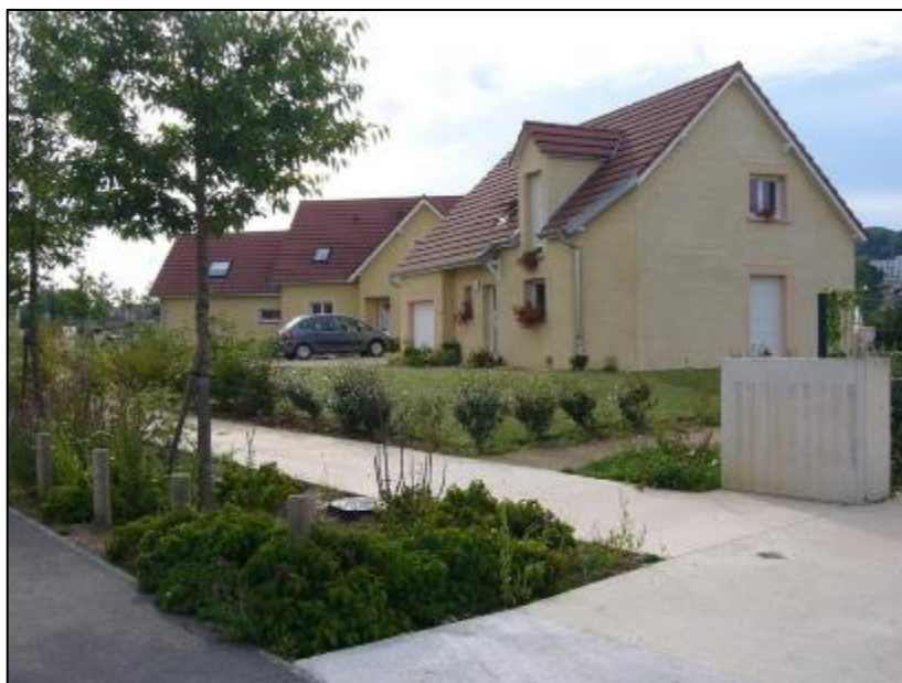
Figure 39 : Photo d'une noue plantée avec piétonnier (IS)
