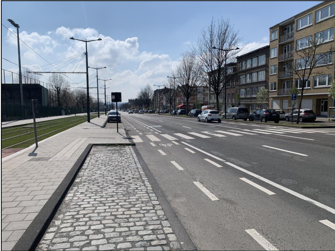
Figure 17 : Exemple de voirie « moyennement facile » à déconnecter, Avenue Houba de Strooper à Bruxelles Ville (IS)
