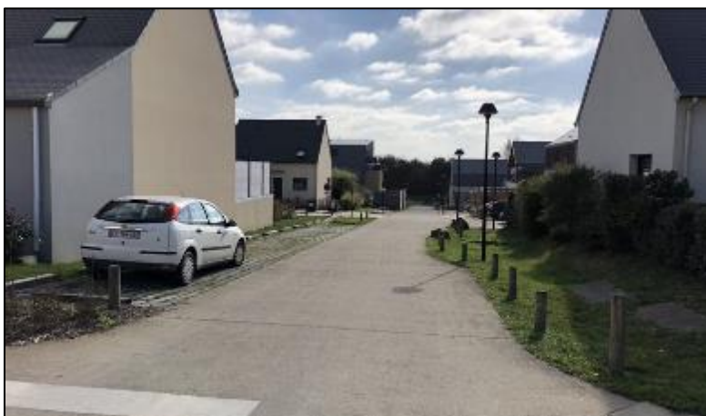
Figure 42 : Photo d'une voie de lotissement en structure drainante (IS)
