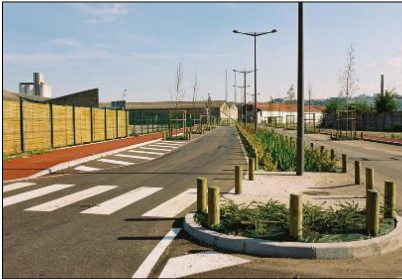
Figure 40 : Photo d'une noue centrale plantée (IS)
