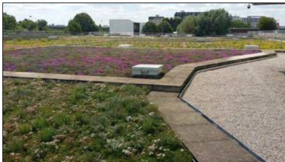
Figure 48 : Toiture végétalisée (Flexirub)
