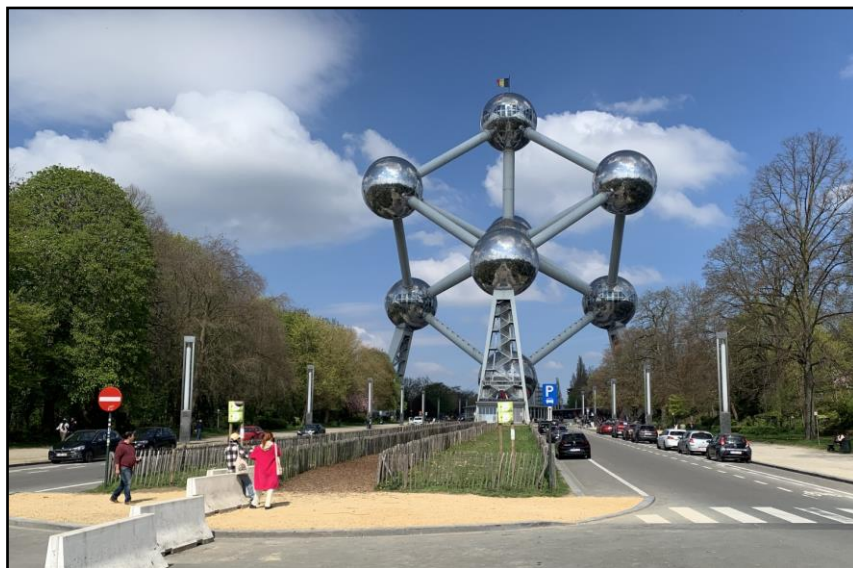
Figure 16 : Exemple de voirie « facile » à déconnecter, Boulevard du Centenaire à Bruxelles Ville (IS)
