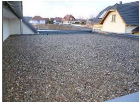
Figure 46 : Toiture gravillonnée (Soprema)
