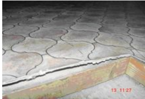
Balatum met een vrij kenmerkend motief, waarvan de gekartonneerde onderlaag licht gebonden asbestvezels bevat
