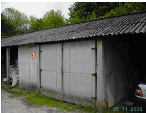
Dubbele deur en wanden van een opslagplaats in asbestcement. Bedekking bestaat uit golfplaten van asbestcement.
