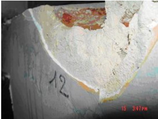
Dunne afwerkingslaag op muur in asbesthoudende pleister
