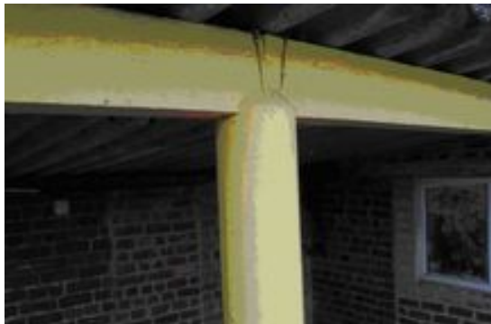
Leiding in asbestcement, gebruikt als verloren bekisting voor een steunpaal van een binnenplaats. De externe wafelstructuur is kenmerkend.
