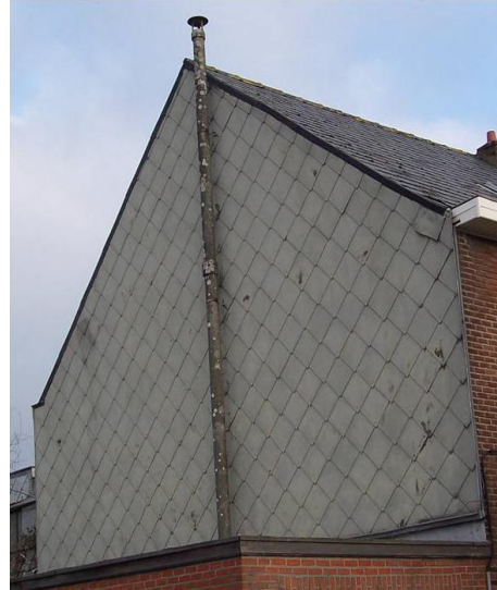
Dak, gevel en schouw in asbestcement
