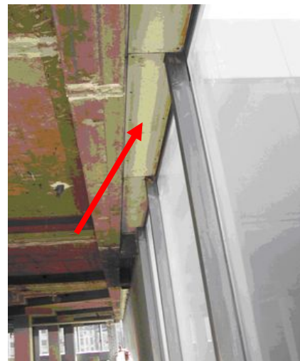
Brandwerende platen van het type 'Pical' ter afsluiting van de ruimte tussen de betonnen vloerplaat en de gevel (foto genomen in een kantoorgebouw)
