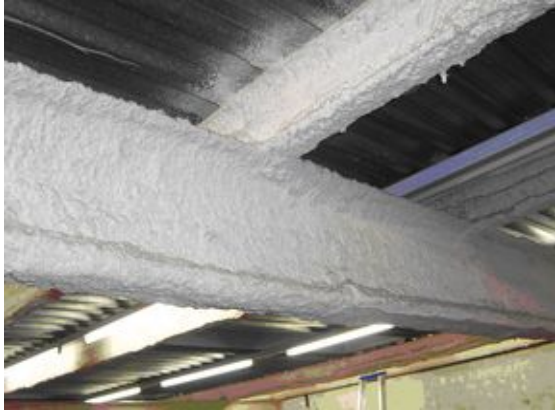
Harde asbestbepleistering op metalen steunbalken gespoten.
