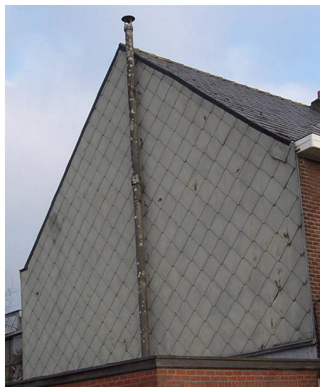
Toiture et cheminée en amiante-ciment
