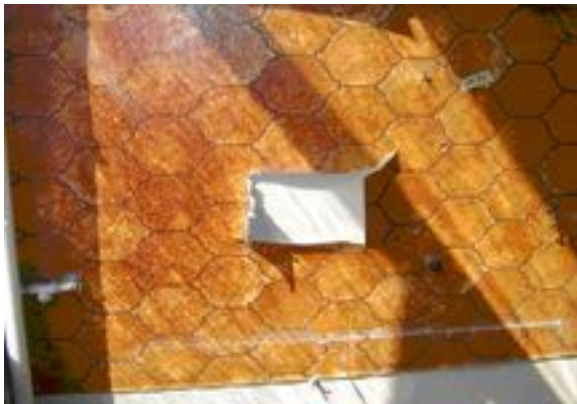
Balatum au motif assez caractéristique, dont la sous-couche cartonnée contient des fibres d'amiante faiblement liées
