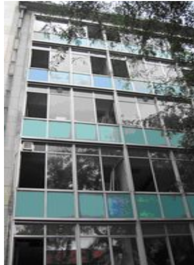
Panneaux en amiante-ciment de type « Glasal » en allège sur une façade (couche de finition extérieure bleu-vert)
