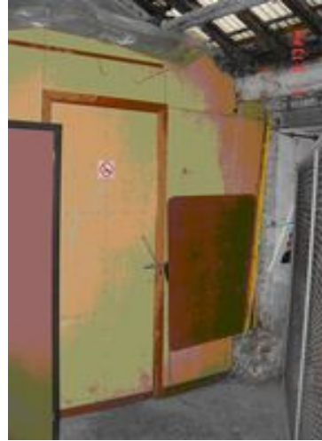
Cloison constituée par de fines plaques jaunâtres de type « Menuiserite »
