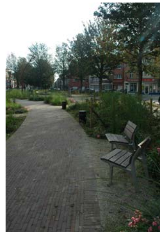
Anderlecht, Jean Reysquare, Gebakken klinkers en dolomiet
