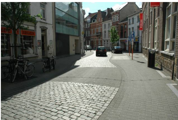
Hasselt : gemengde weg - natuursteenkeien / betonstraatstenen.
