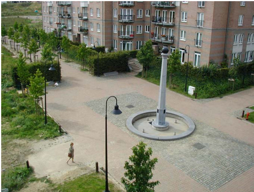
Jette, De tuinen van Jette – Betonstraatstenen in een wandelstraat
