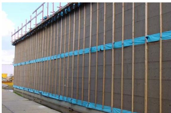
Un panneau isolant semi-rigide en fibre de bois du côté extérieur de l'ossature bois assure à la construction l'étanchéité au vent et à l'eau. Ce panneau est en outre ouvert à la vapeur afin de laisser sortir vers l'extérieur la vapeur présente dans la construction.
