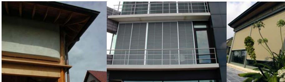
Débordement de toiture (Arch. Marc Depreeuw) - Lamelles (Loggia – Renson) – Stores extérieurs (Fixscreen Renson)
