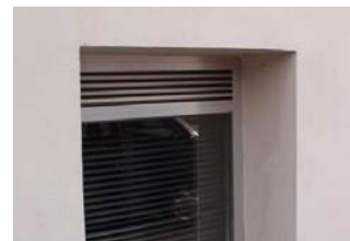
Débordement de toiture (Arch. Marc Depreeuw) - Lamelles (Loggia – Renson) – Stores extérieurs (Fixscreen Renson)
