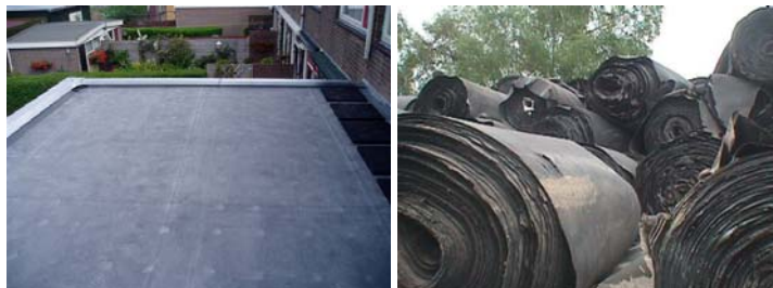
La membrane EPDM est moins sujette aux phénomènes de dilatation thermique et de retrait.
