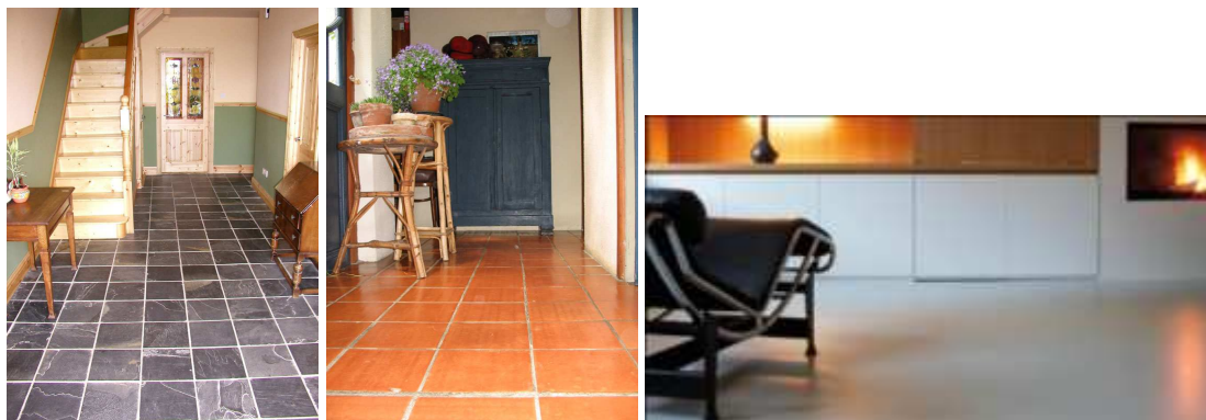
Finition du sol en pierre de schiste, céramique et béton poli
