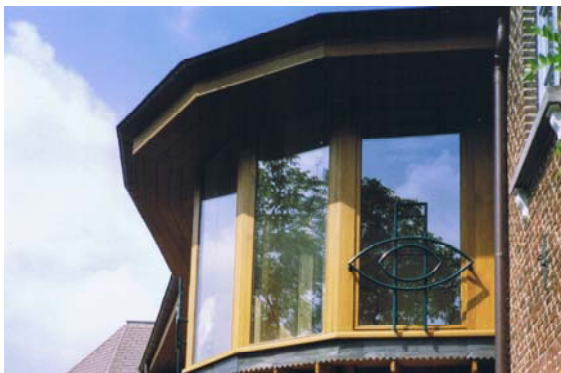
Grote ramen zorgen in de zomer voor oververhitting. Een dakoversteek tempert de hoogstaande zomerzon, maar laat een laaghangende winterzon toch nog binnenschijnen. (Foto: VIBE vzw)
