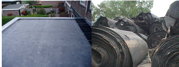
Het EPDM membraan is minder onderhevig aan fenomenen van thermische uitzetting en inkrimping.
