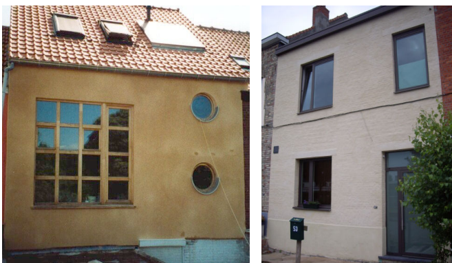
Een natuurlijke hydraulische kalkmortel (foto 1) en kalei (foto 2) zijn milieuvriendelijke oplossingen. Bron: www.artefino.be (foto 1); www.tintelijn.be (foto 2)
