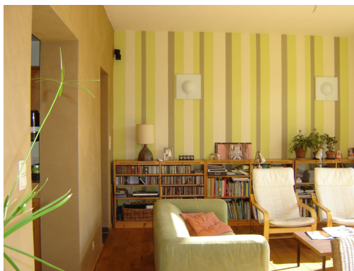
Gipsvezelplaat geschilderd met natuurverf
