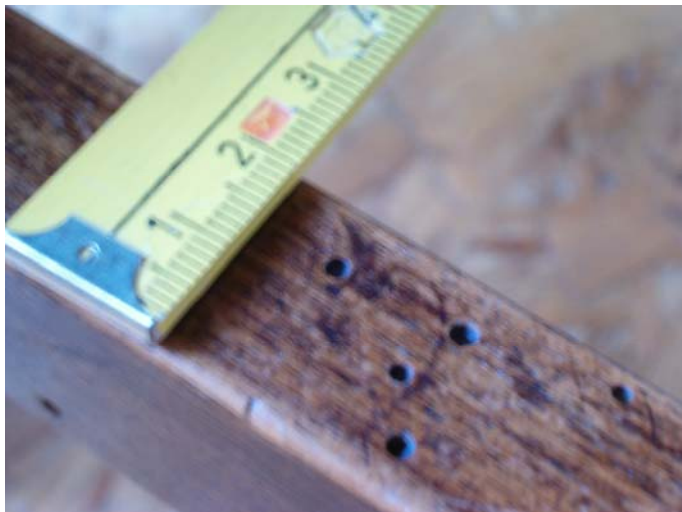
Foto: aantasting door de kleine klopper
