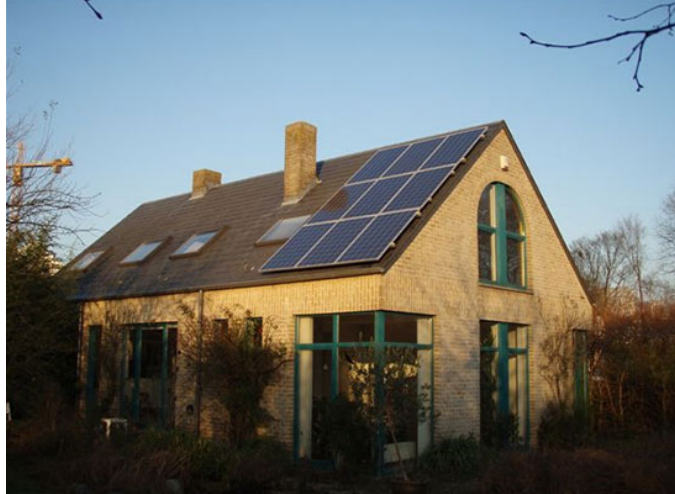
Figure 6 : Installation de 2 kWc - Bruxelles, BELGIQUE (Photo Issol)
