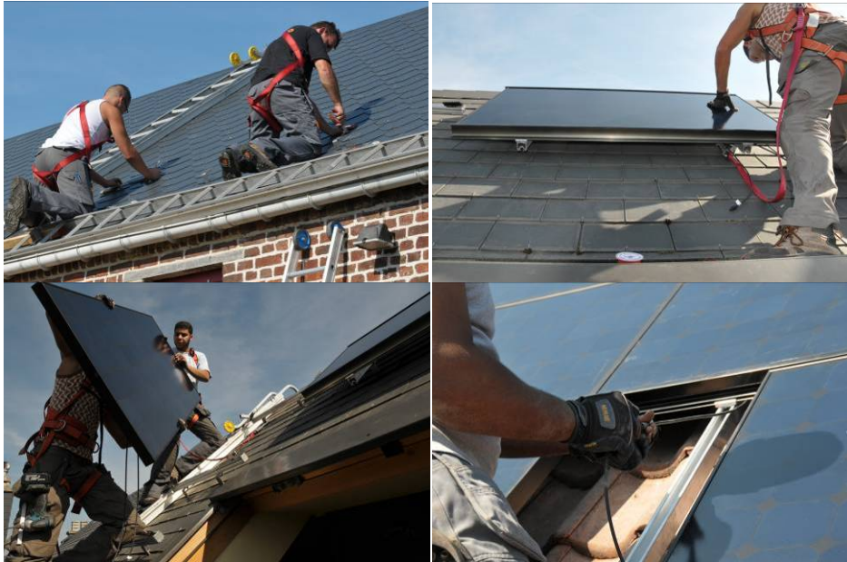
Figure 8: Installation des modules en toiture (Photos SunSwitch)
