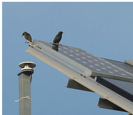
Figure 1 : les ombres temporaires (dus par exemple aux oiseaux ou à leurs déjections) peuvent diminuer la puissance du module concerné mais également de tout le string
