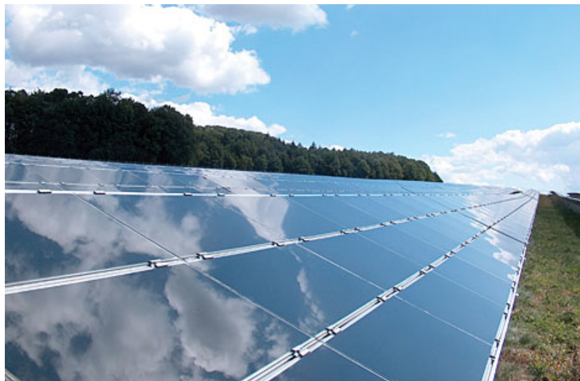
Figure 7 : modules verre-verre au Telluride de Cadmium, efficacité de 9 à 11%
