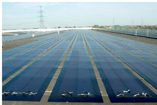
Figure 4 : système constitué de modules au silicium amorphe collés sur la membrane d'étanchéité de la toiture. Projet Colruyt, Halle. [Photo Colruyt].
