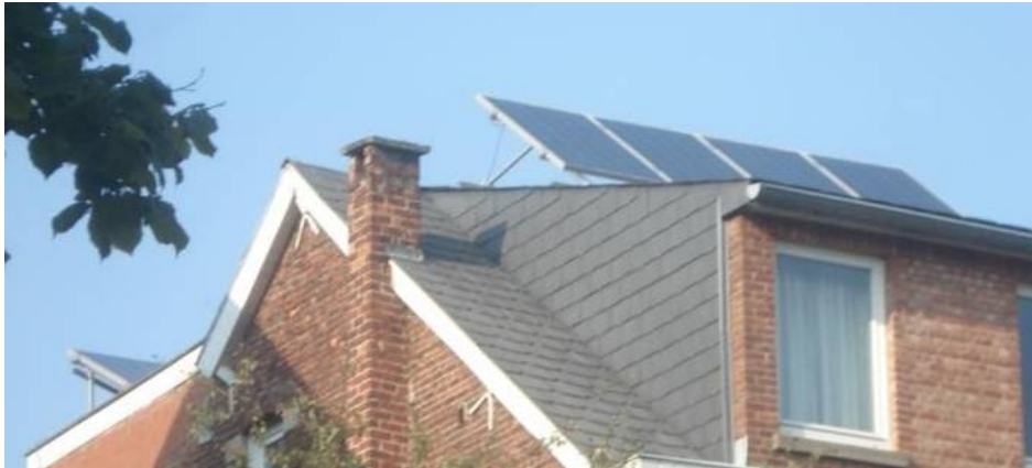
Figure 1 : Permis nécessaire car non respect du parallélisme entre le plan du toit et les panneaux et visible de la rue
