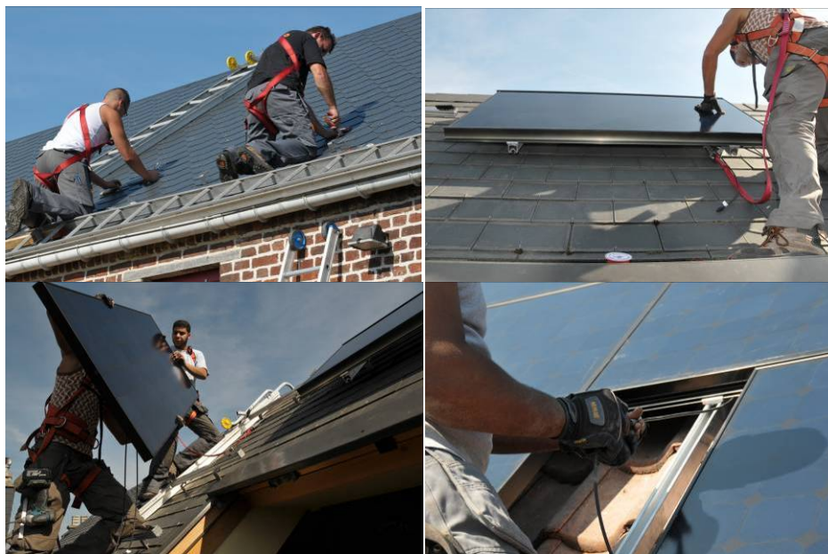
Figuur 8: Opbouw van panelen (foto's SunSwitch)
