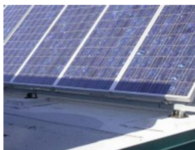
Figuur 8 : Voorbeeld van een schaduw die bijna 100% productieverlies veroorzaakt
