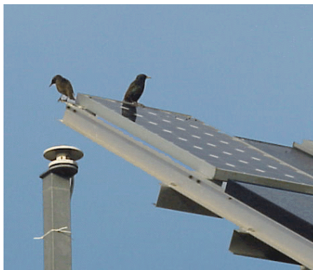
Figuur 1 : Tijdelijke schaduwen (bijvoorbeeld veroorzaakt door vogels en hun uitwerpselen) kunnen het vermogen van het paneel en zelfs van de hele string negatief beïnvloeden
