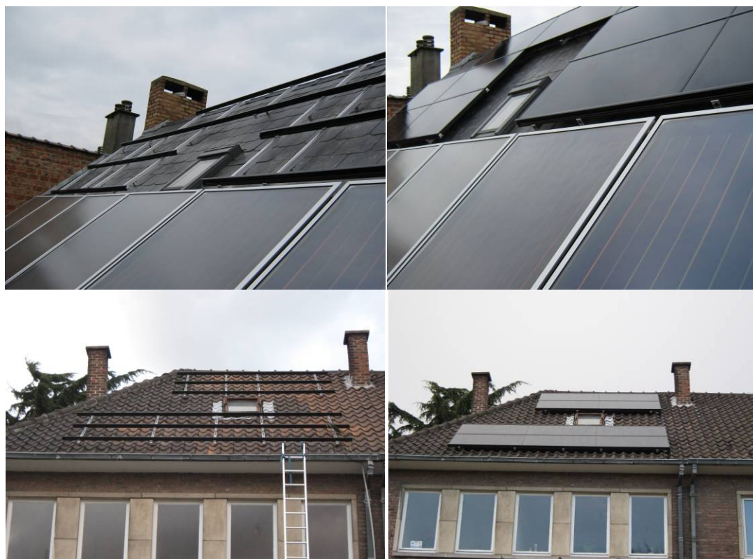
Figuur 9: Voor en na de plaatsing van zonnepanelen (Foto's SunSwitch)
