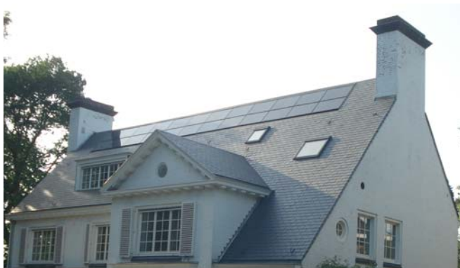
Figuur 10: Geïntegreerde modules - APERE
