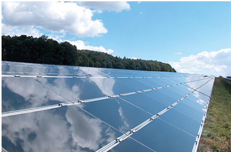
Figuur 7 : Glas-glas panelen van cadmiumtelluride, efficiëntie van 9 tot 11%
