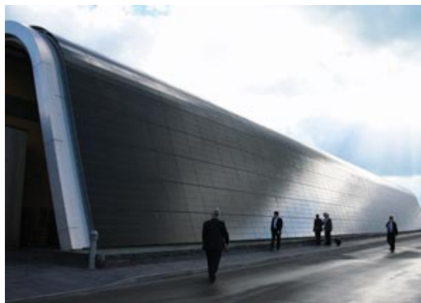
Figuur 8 : CIGS-gevel in Wales, efficiëntie van 8,5%
