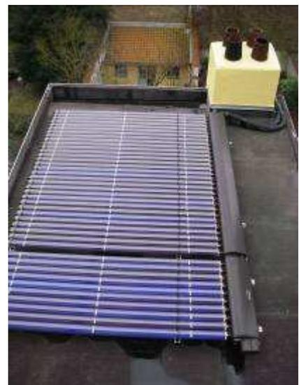
Figure 1. capteurs tubulaires sous vide
