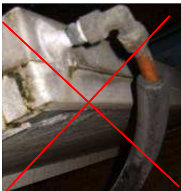
Figuur 2. geen isolatie van kniestuk
