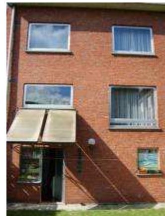
Figuur 1 . oude collectoren
