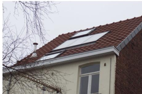
Du moment qu'ils soient orientés entre l'est et l'ouest (en passant par le sud), les capteurs solaires peuvent être installés sur les toitures des maisons unifamiliales, des immeubles à appartements ou des copropriétés. Il est aussi possible de les placer en façade ou sur un toit plat !
