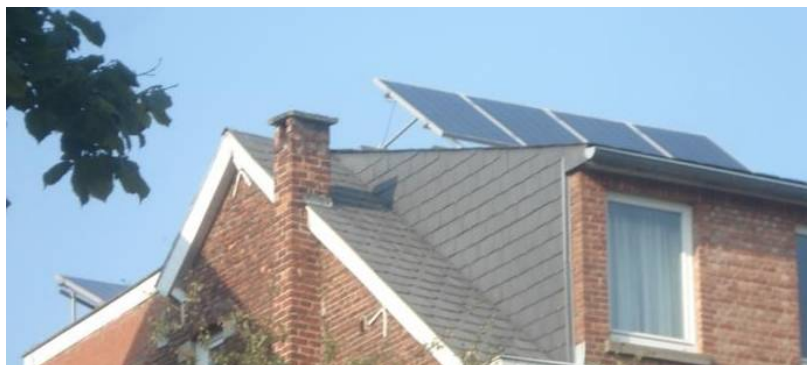
Figuur 1: een vergunning is noodzakelijk, want de panelen staan niet parallel met het dak en zijn zichtbaar vanop straat
