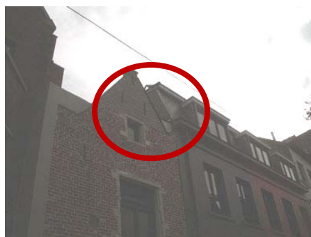
Figuur 2: een randgeval waarbij de panelen amper zichtbaar zijn vanop straat
