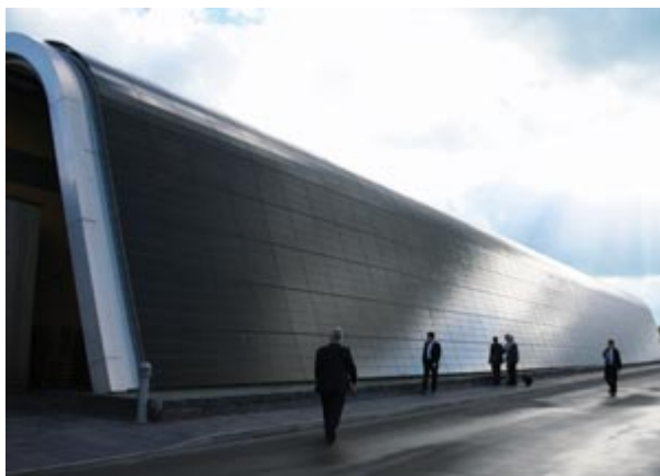
Figuur 8 : CIGS-gevel in Wales, efficiëntie van 8,5%
