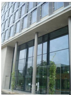
Fig 1 : La façade arbore des laminés monocristallins qui assurent également la fonction de pare-soleil.
