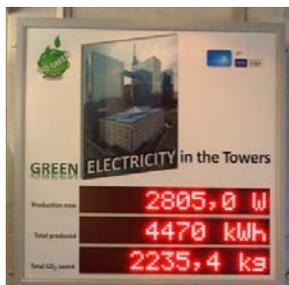
Le système photovoltaïque est agrémenté d'un système de monitoring et d'affichage de la production, installé en évidence à l'entrée des deux fameuses tours.
