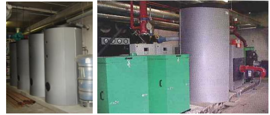
les ballons de stockage solaire (photo de gauche) les 2 cogénérateurs et la chaudière à condensation (photo de droite)
